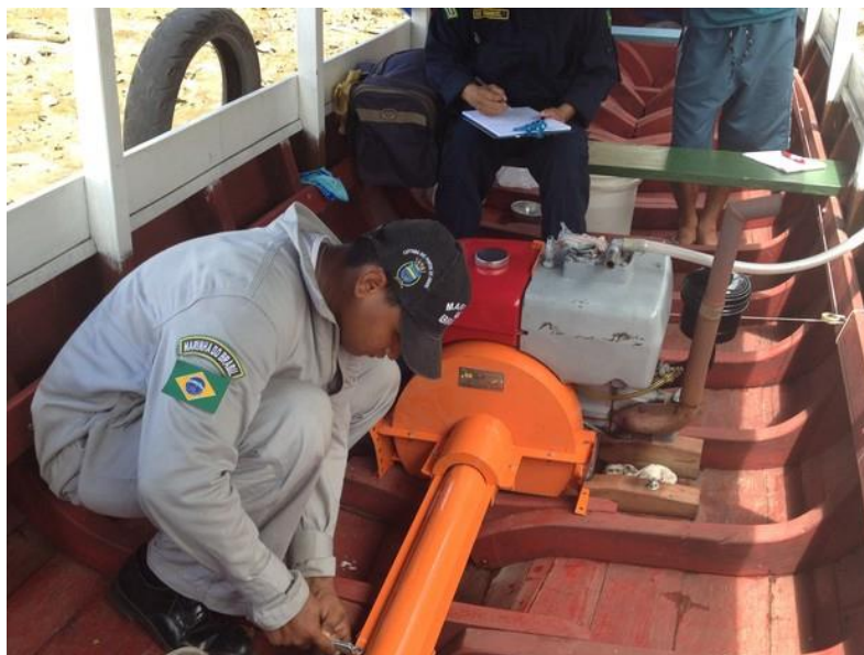
Figura 27 – Capitania dos Portos instalando eixo de proteção
